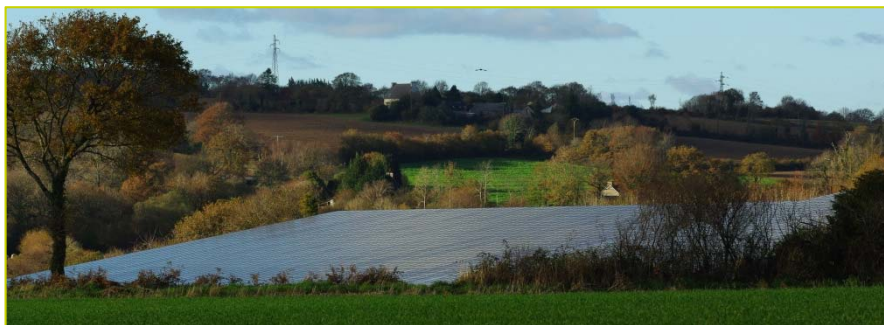
# Installation photovoltaïque sur hangar agricole à Brie de l'Odet
