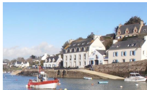
Quai de Kernabat, à Doëlan, construit en 1825 pour l'accueil de chaloupes sardinières
