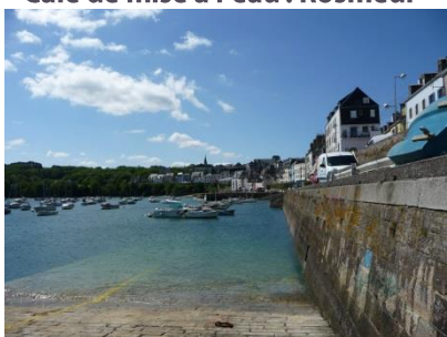
Cale de mise à l'eau : Rosmeur
