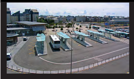
Gare routière de Saint-Malo
