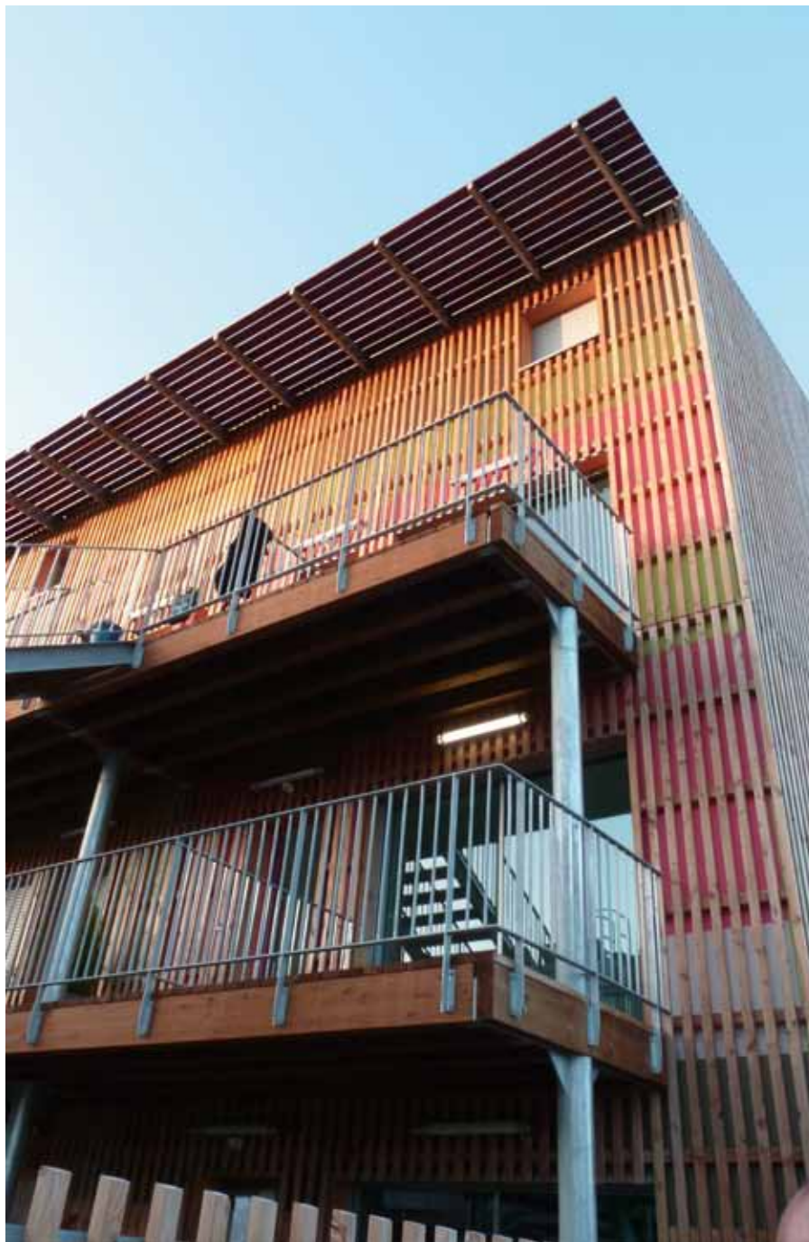
Bois Soleil, réalisation OPPIDEA, logement abordable quartier de Borderouge
