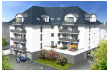
EMELGE : « Résidence ARCHIMEDE »
