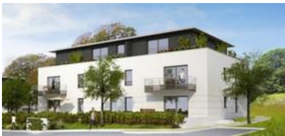
AIGUILLON CONSTRUCTION « Hémérica » Collectif T2 à T4 en investisseur et PSLA T2-T3
