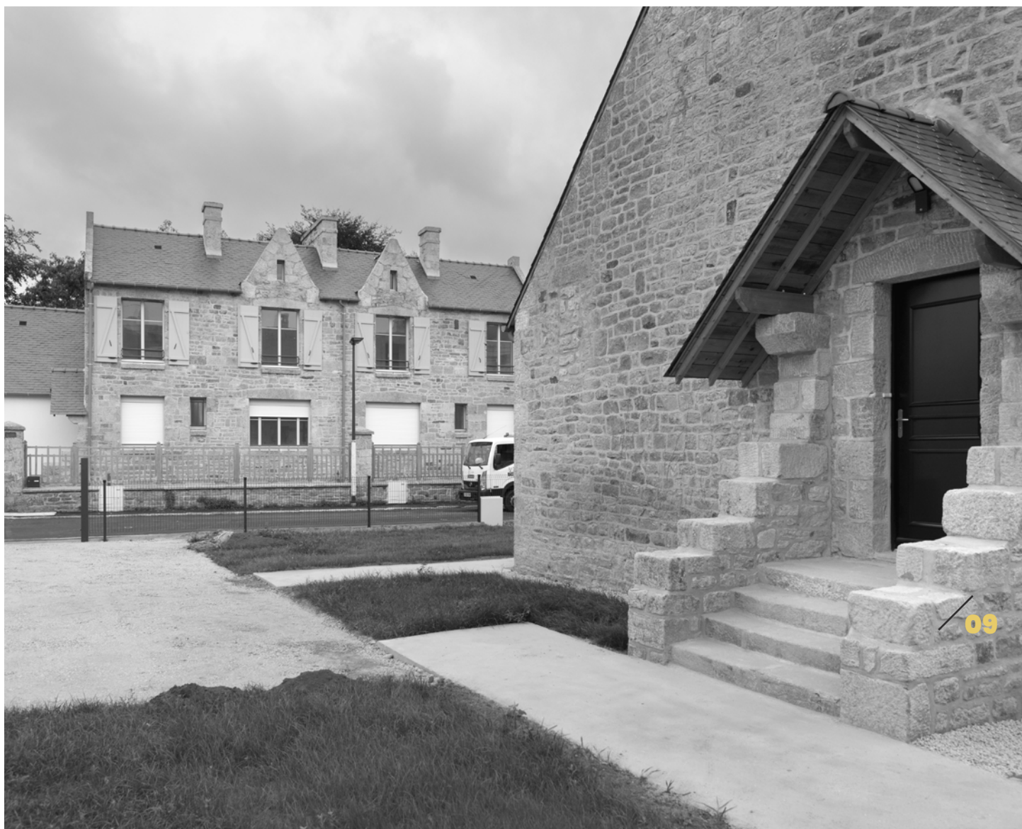
Quimper – Cité du gaz
