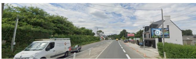
Entrée au sud, via la D34 – Traversée d'une Zone d'Activités et d'espaces pavillonnaires
