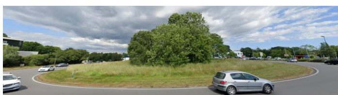
Entrée au sud-est, via la D783 (Giratoire d'Ergué Armel) – Giratoire et pourtour densément végétalisé
